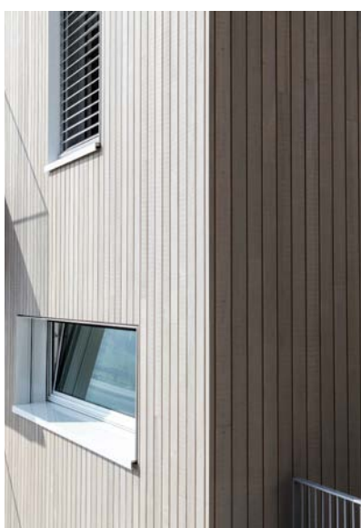
Weisstannenfassade, sägeroh/Façade de sapin blanc, brut scié
